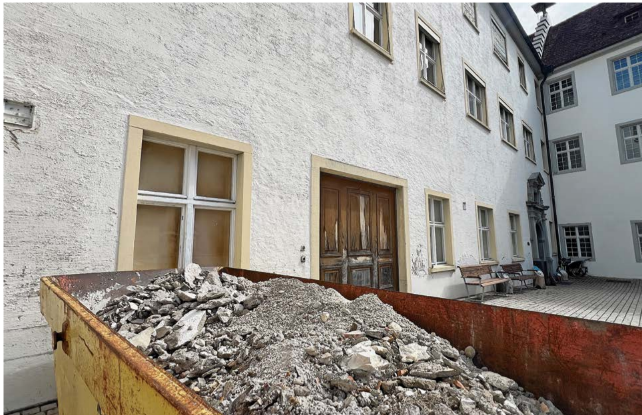
Der Abtrakt, der letzte ungenutzte und unsanierte Flügel des ehemaligen Klosters, kann zur Baustelle werden.
