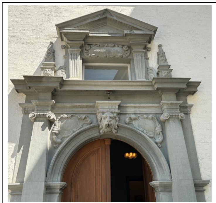
Portal des Abteitraktes von 1678.
