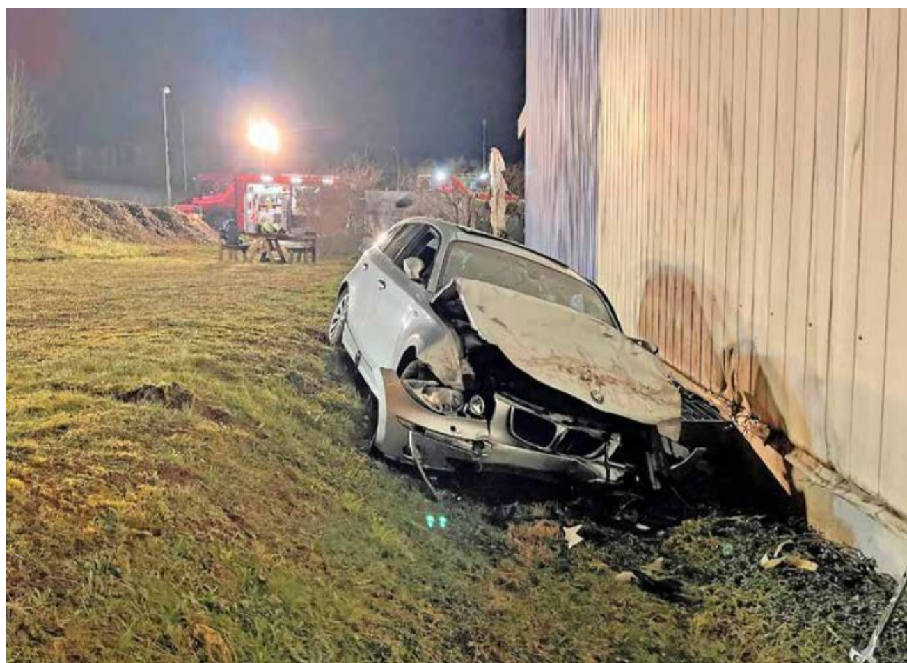
Das Unfallauto prallte in die Wand eines Gebäudes und erlitt Totalschaden.
